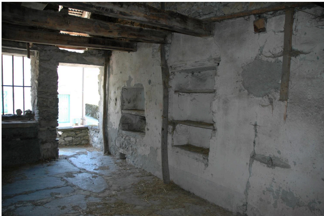
Vue intérieure de la cuisine : étagère et niche à eau.
