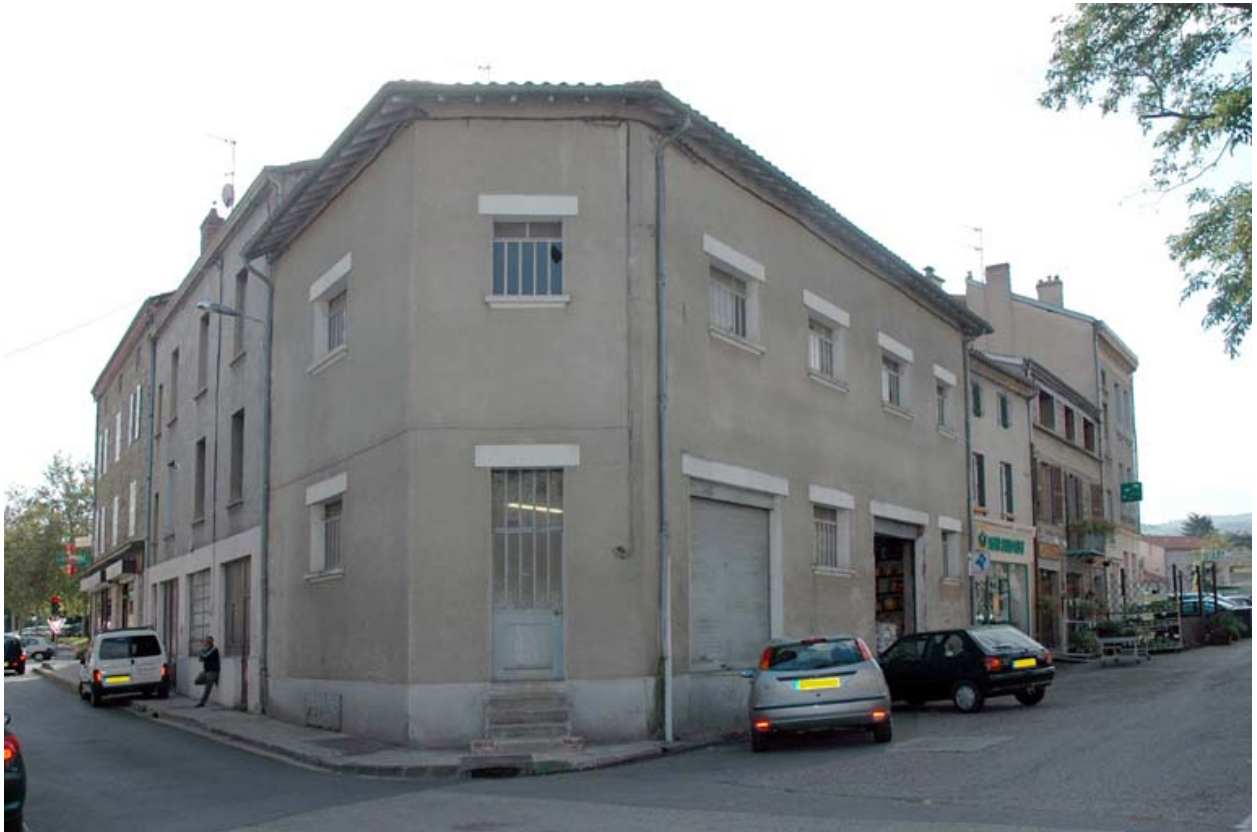
Ancien atelier de serrurerie situé 6 quai L'Astrée.
