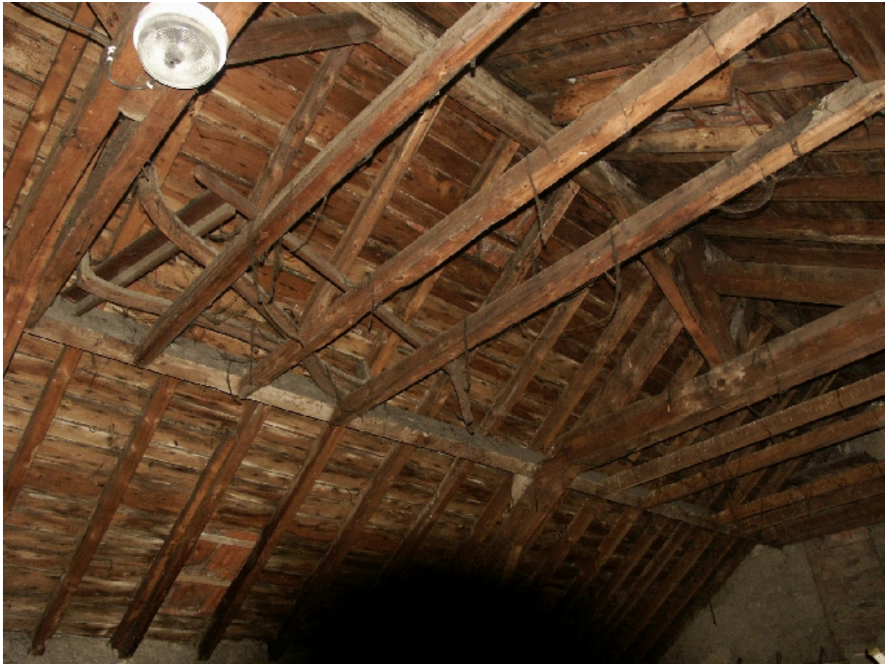
Détail de la charpente
