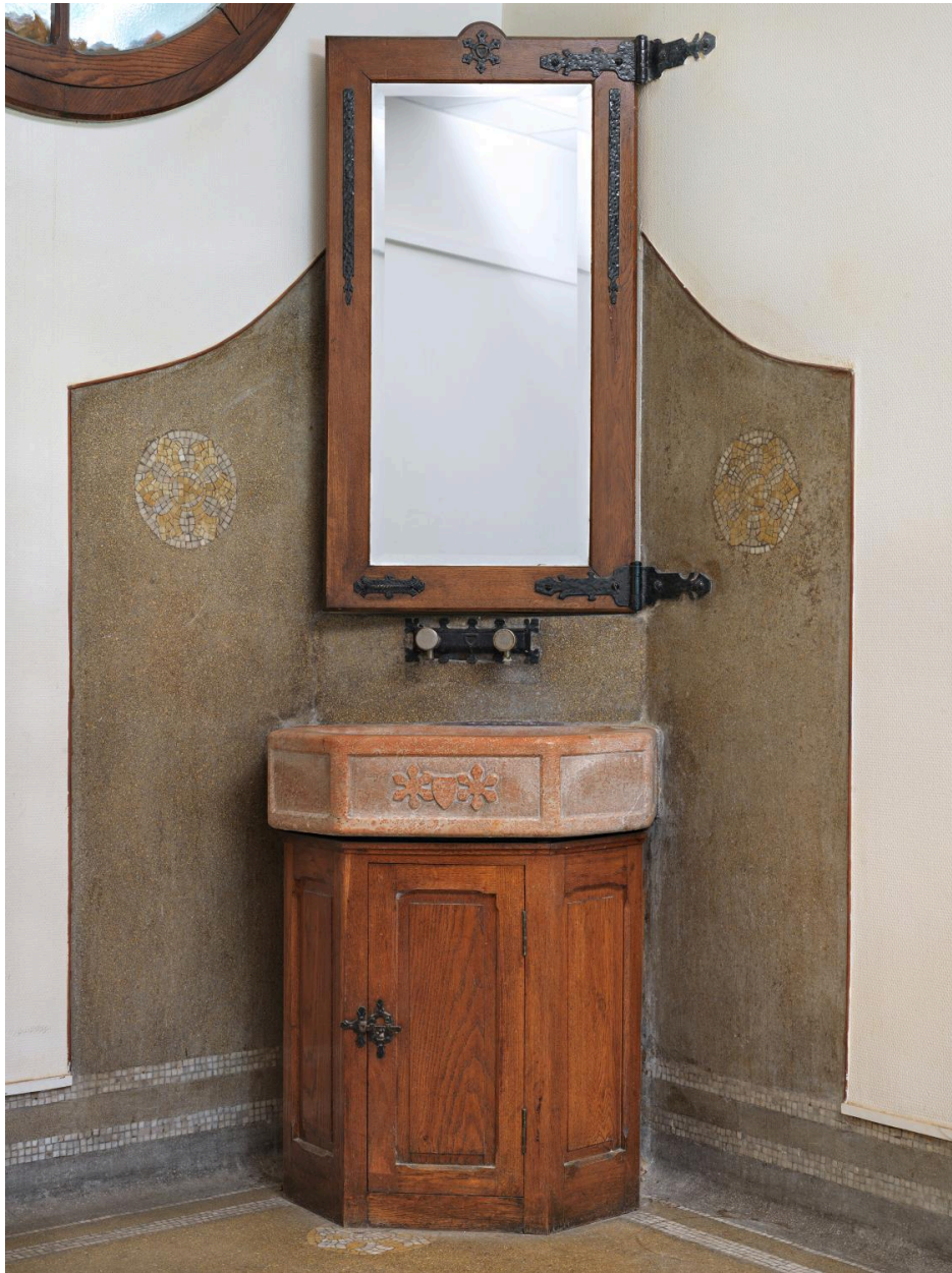
Vestibule : lave-mains maçonné et miroir pivotant porte-essuie-mains (fermé)
