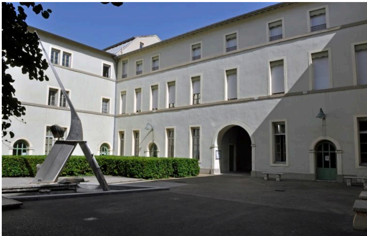
Bâtiment D : élévation sur cour 1 depuis le sud-est
