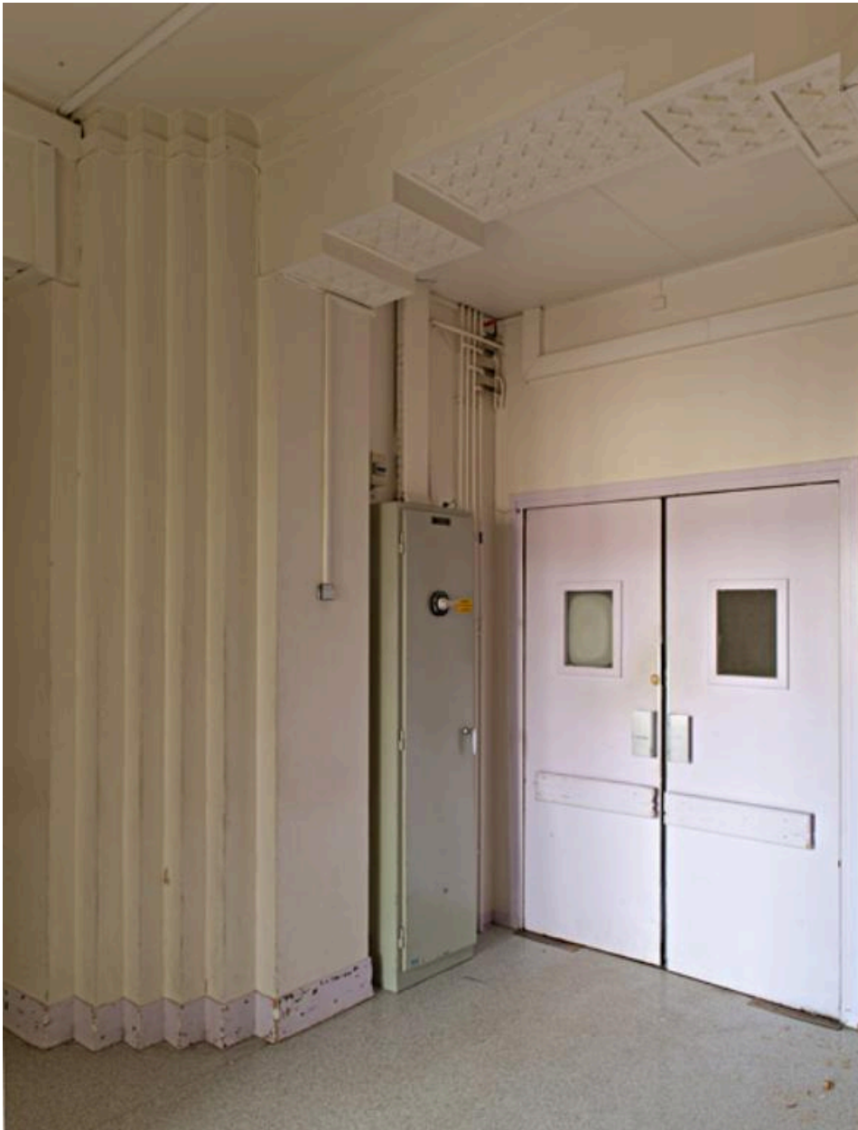
Hôtel-Dieu de Clermont-Ferrand. La polyclinique, angle nord-est de l'intersection centrale des couloirs du rez-de-chaussée.
