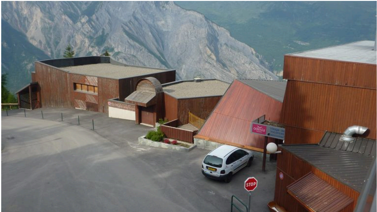
Bâtiment nord vu depuis l'ouest
