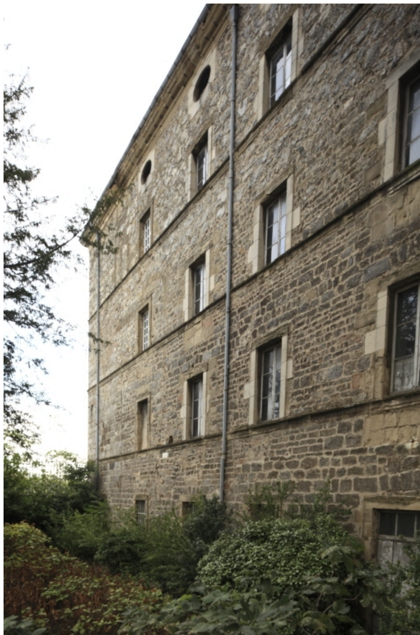
Bâtiment A. La façade septentrionale redessinée au milieu du 19e siècle lors de la construction de la passerelle Seguin.
