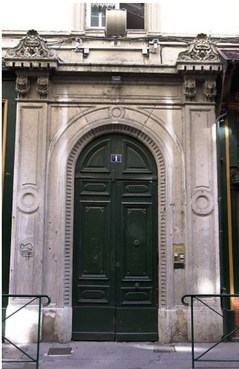
Façade principale, porte
