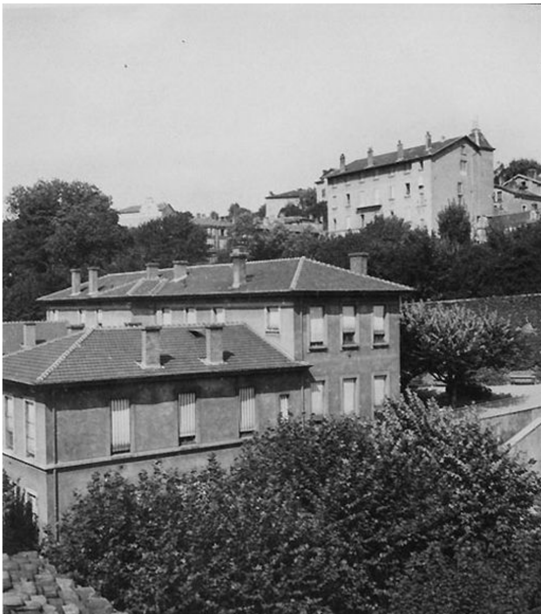
L'Antiquaille. Le service de neurologie [bâtiment 18]. Vue prise des toits du bâtiment dit : St Pothin, fotogr. ca 1930-1935
