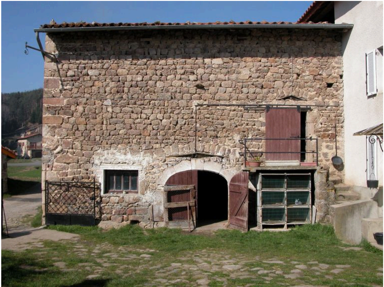
Vue d'ensemble de la façade sur cour de la grange-étable.
