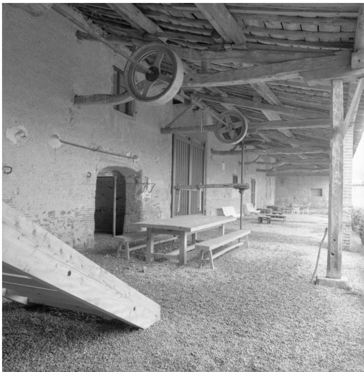
Vue sous la partie couverte précédant le corps de bâtiment ouest, du sud.
