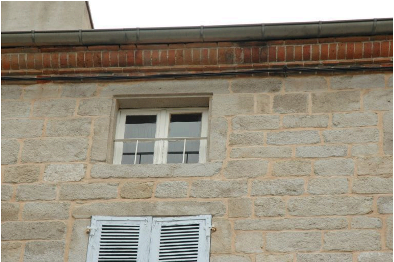
Détail, corniche en brique, en quart-de-rond.
