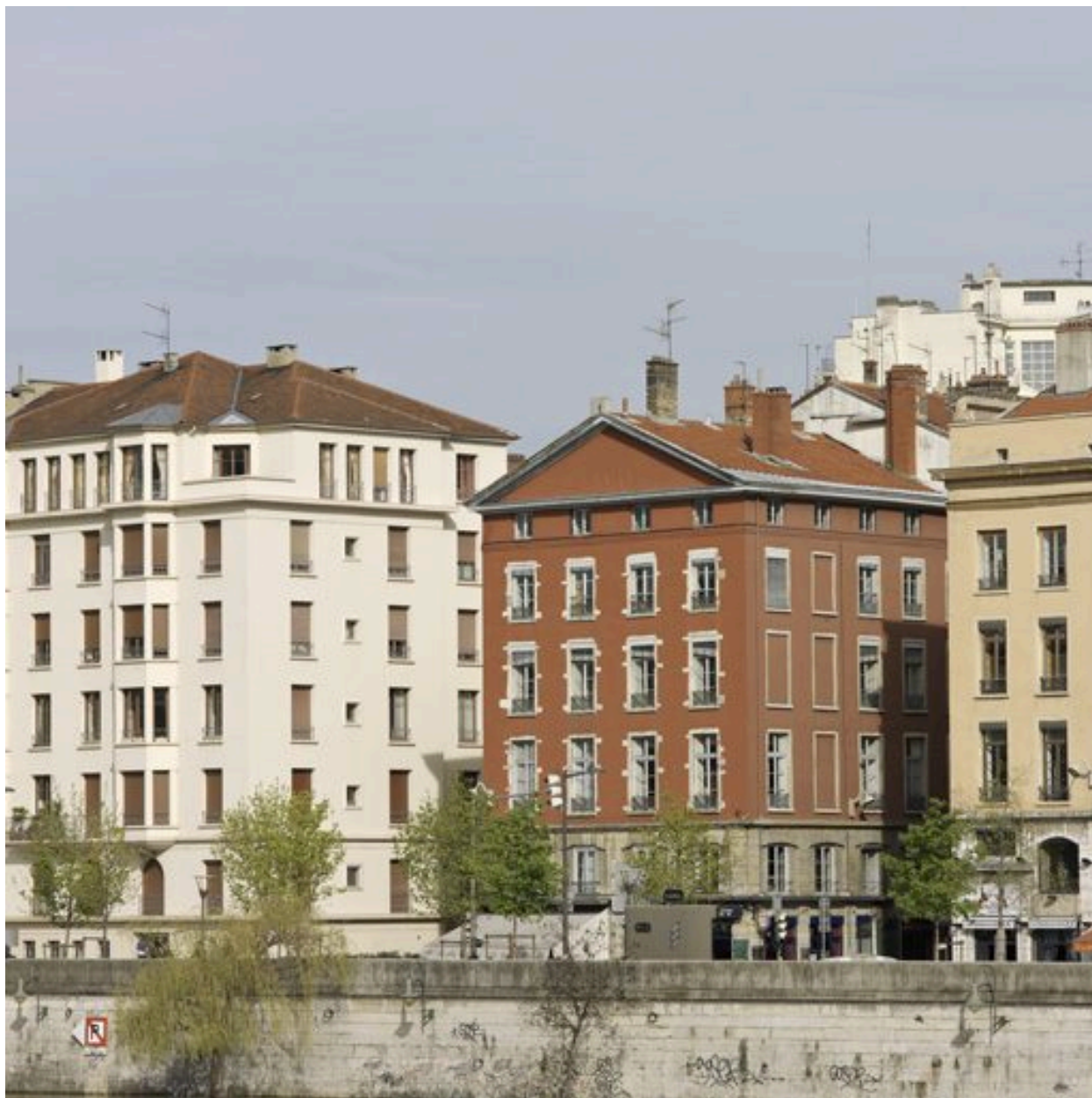
Vue du pavillon construit par la compagnie des Célestins depuis le quai Romain-Rolland
