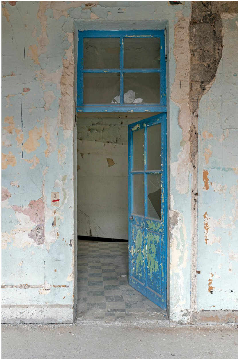
Aile nord, 1er étage : salle principale, détail d'une porte
