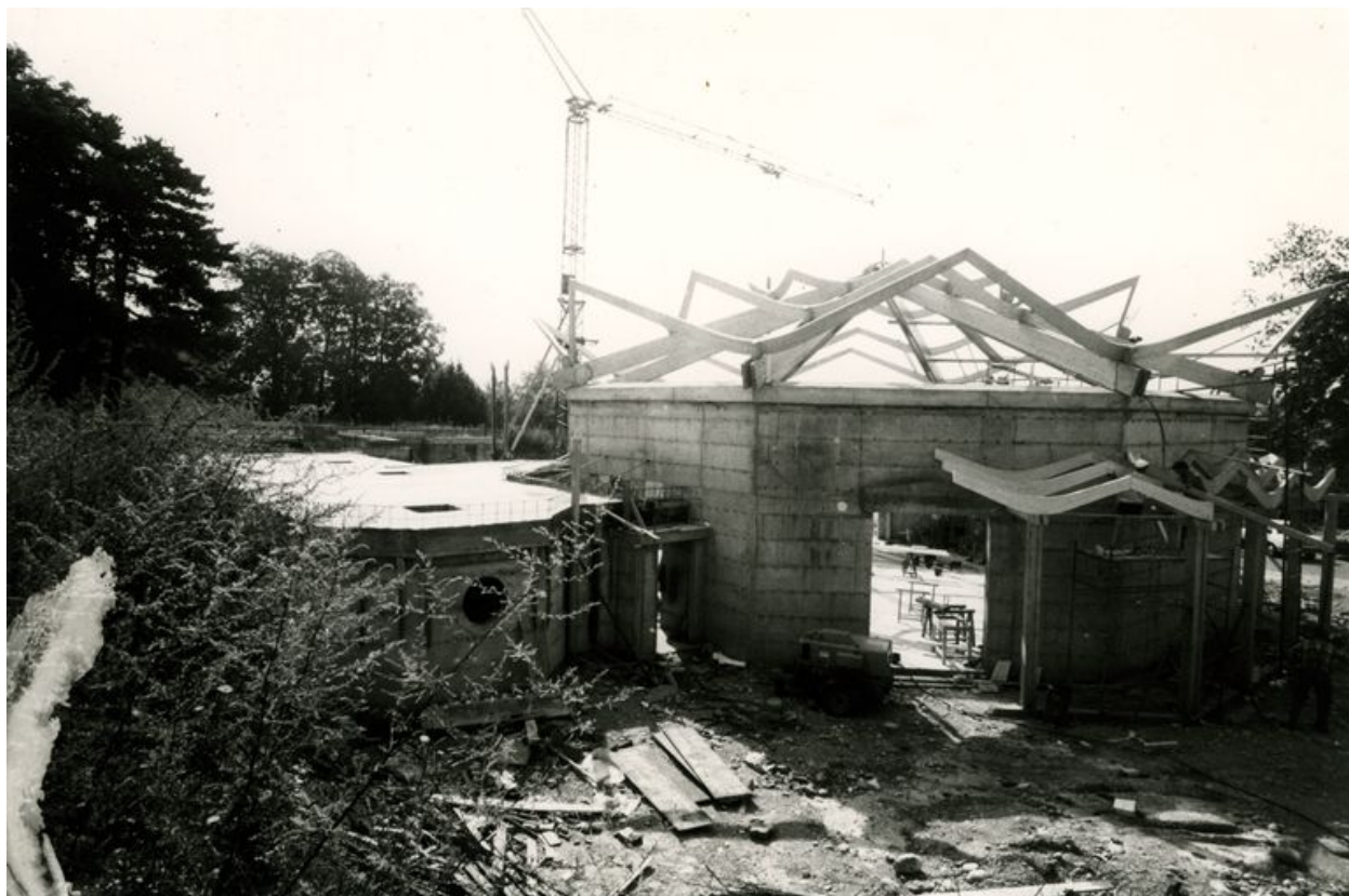
Vue de l'église depuis la place Schönberg, pose de la charpente
