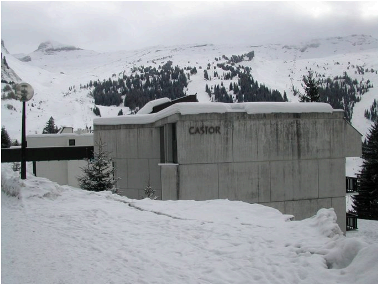
Vue depuis l'ouest
