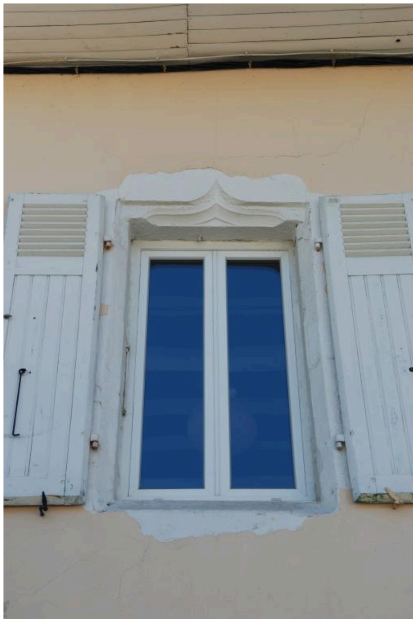
Façade ouest, détail (fenêtre au 1er étage).
