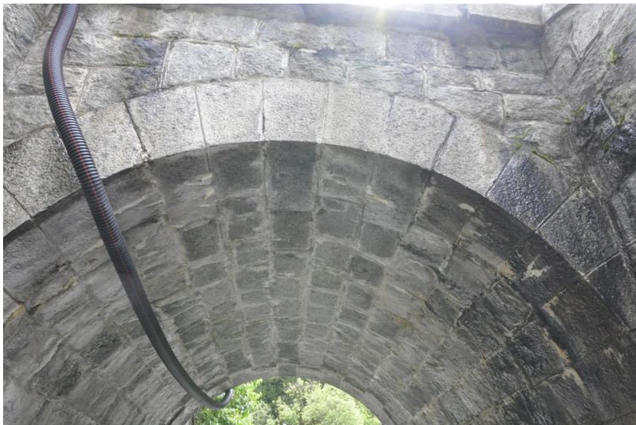
Détail du bandeau de la face ouest
