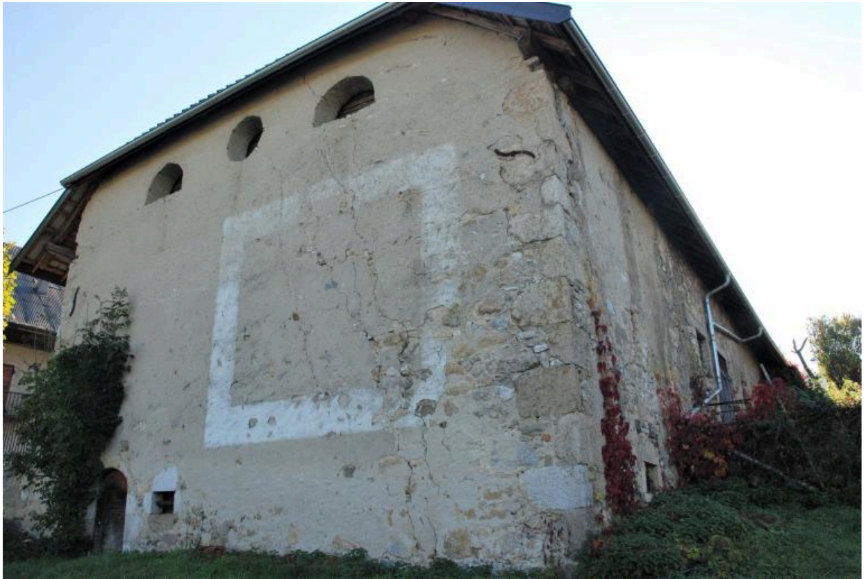
Vue d'ensemble des dépendances agricoles de trois-quarts arrière gauche avec jours du fenil et porte d'accès à la cave.
