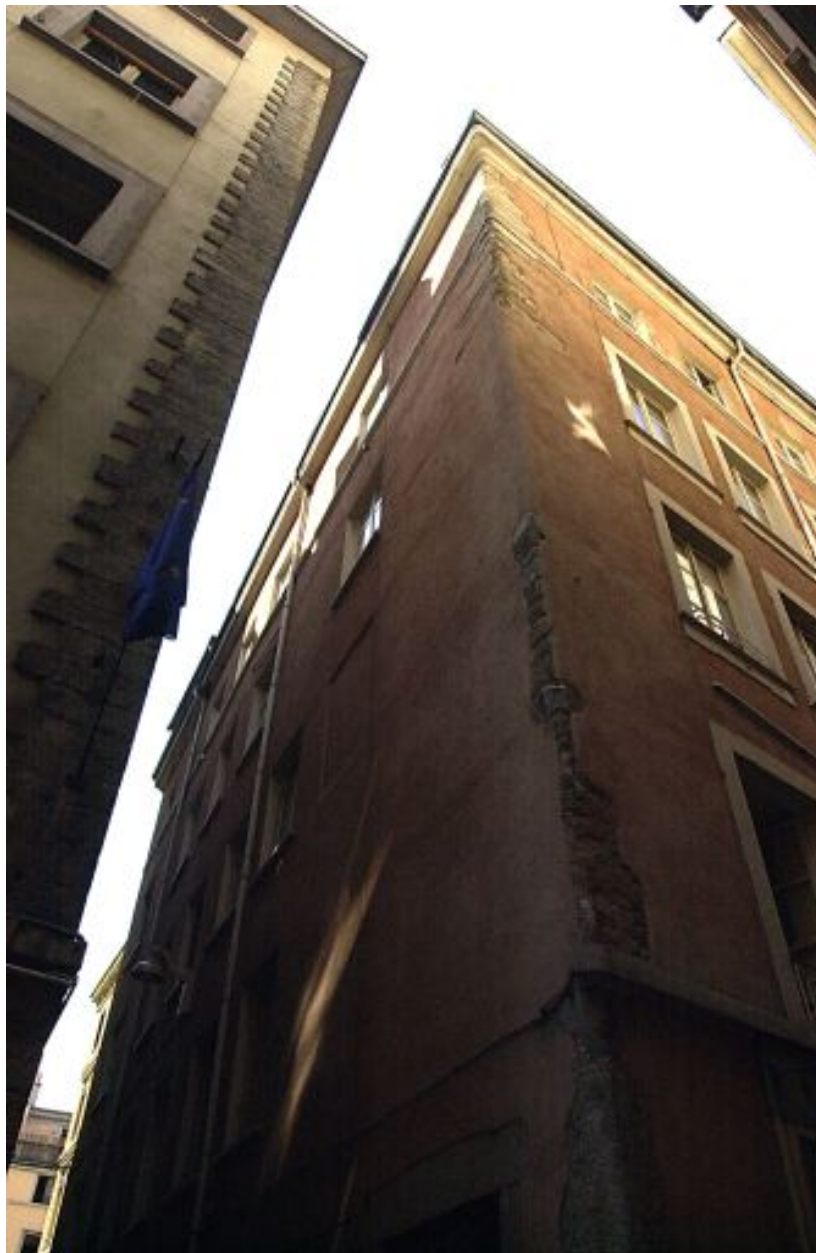
Façade rue Valfenière, étages carrés et chaîne d'angle
