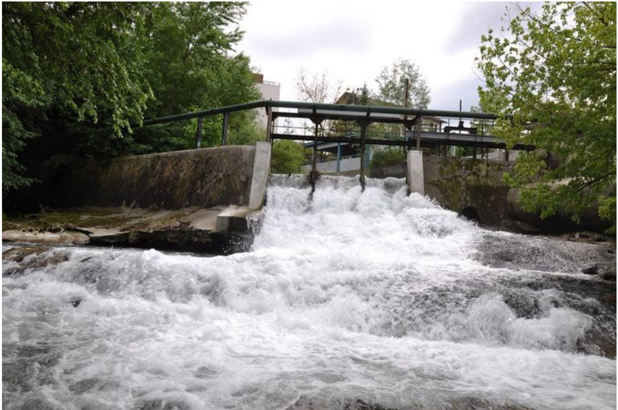
Barrage de la chute de Cran
