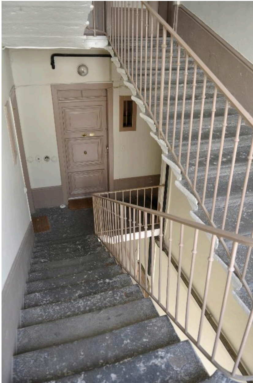
Immeuble sur rue, vue du deuxième palier de l'escalier
