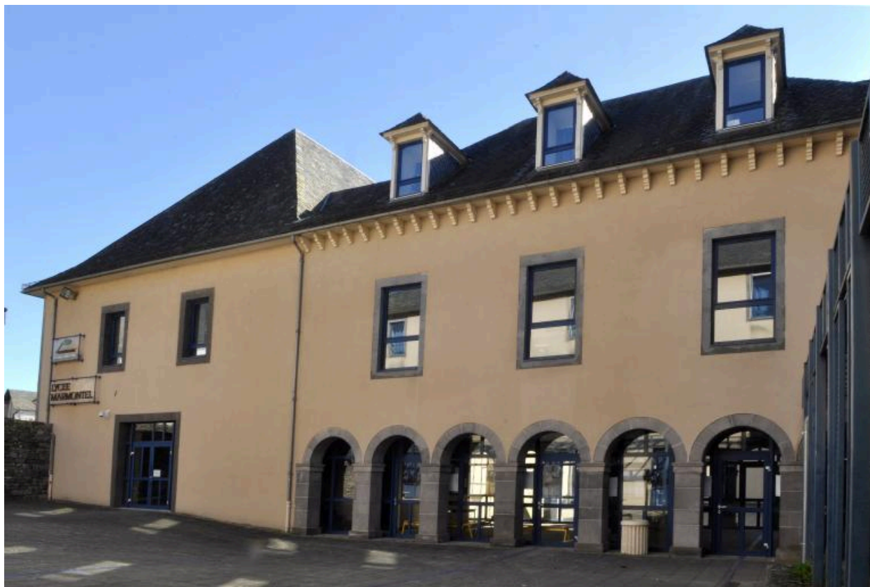
Cour nord : corps de bâtiment sud
