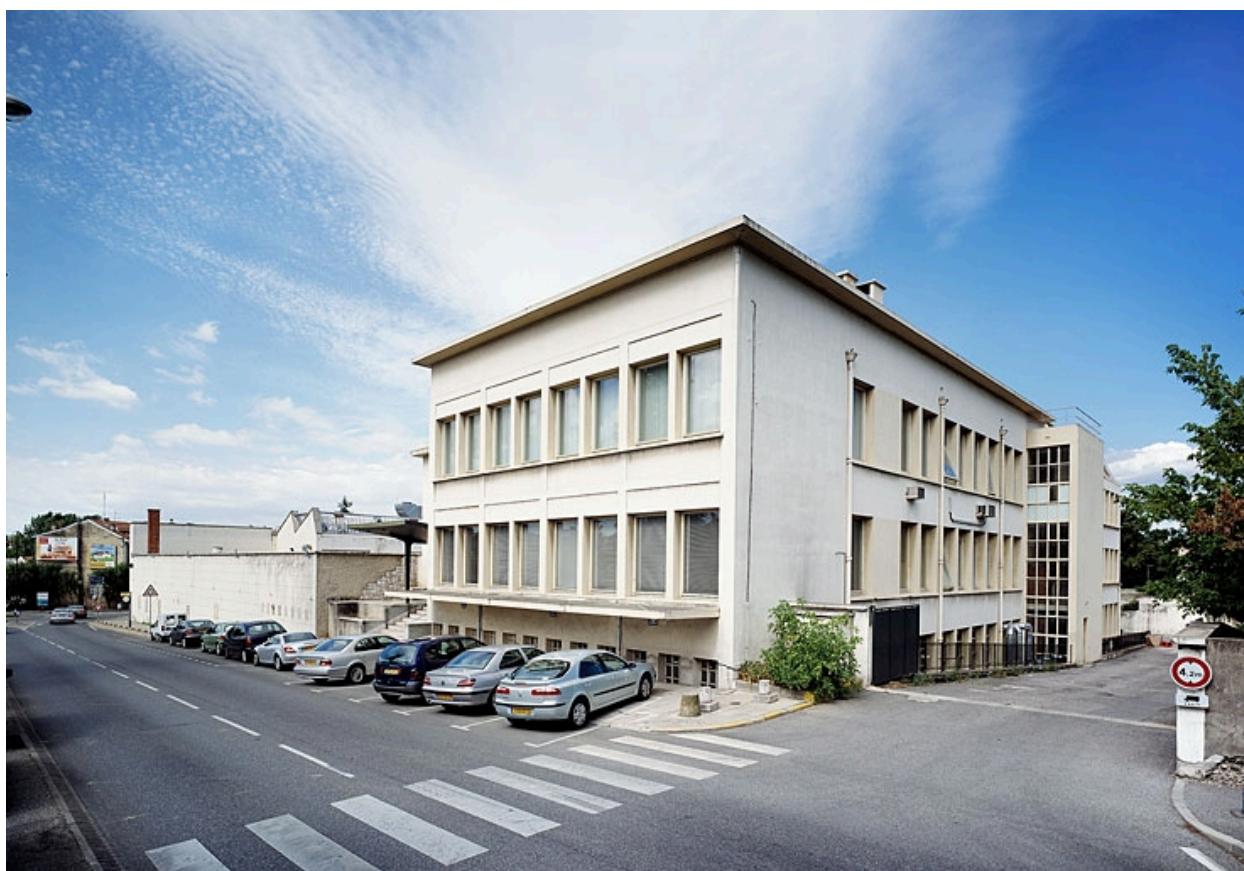
Bâtiment administratif de la Société Charles Jourdan
