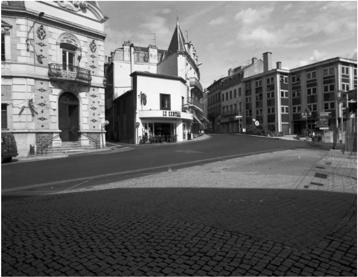
La place depuis le sud-ouest, avant les travaux de réaménagement.
