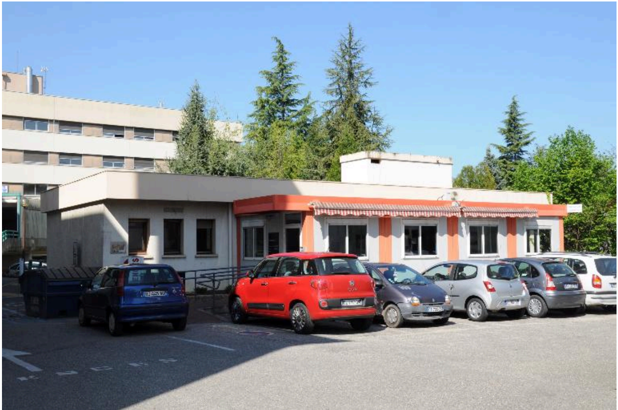
Pharmacie (bât. E), façade est
