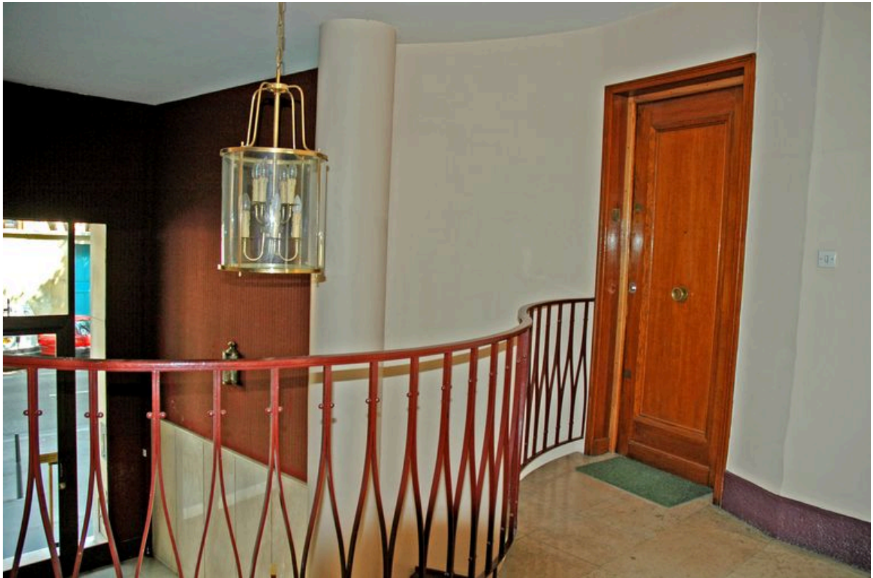
La galerie desservant les appartements de l'entresol
