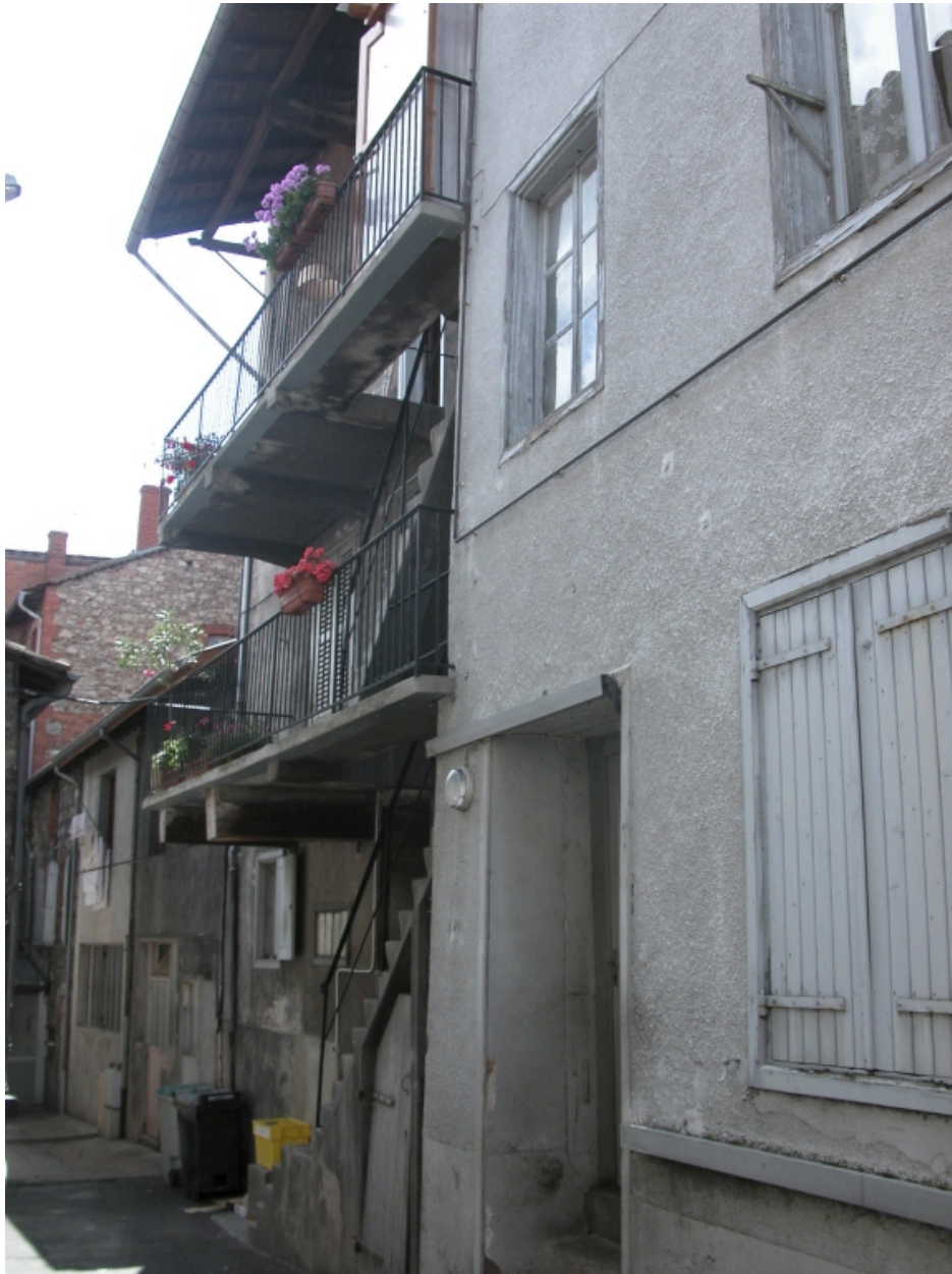
Îlot 2. Roanne (rue de) 03. Vue partielle de la façade sur cour.
