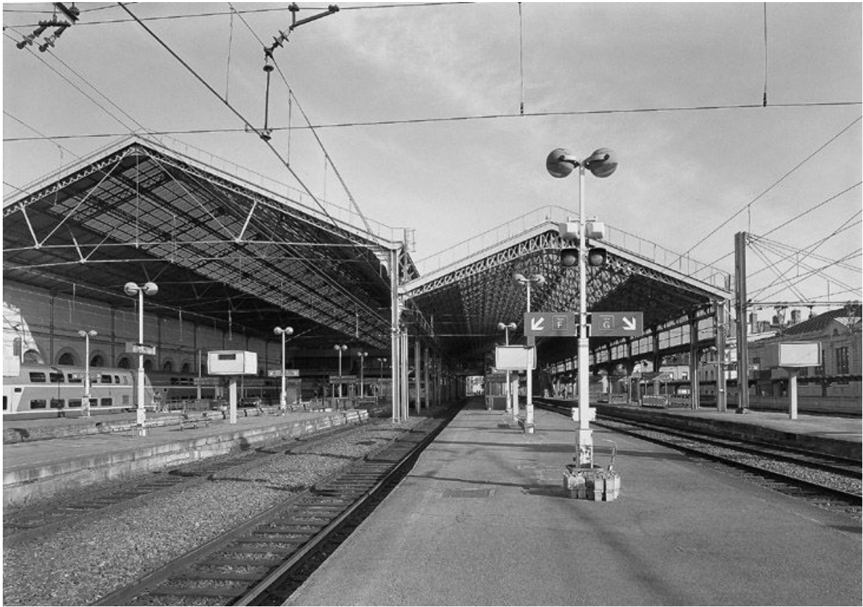
Vue d'ensemble des deux halles depuis l'ouest
