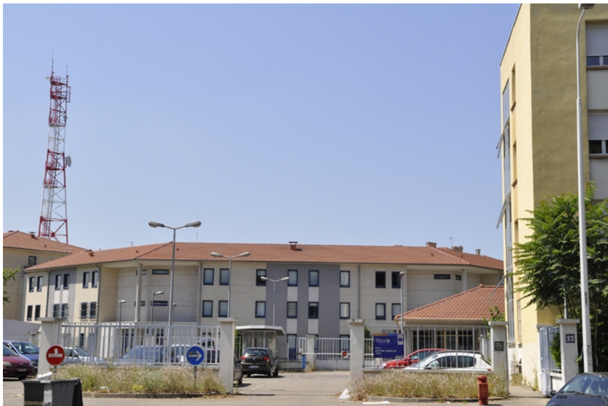
Bâtiment construit dans les années 80, vue prise depuis le boulevard Yves Farges.
