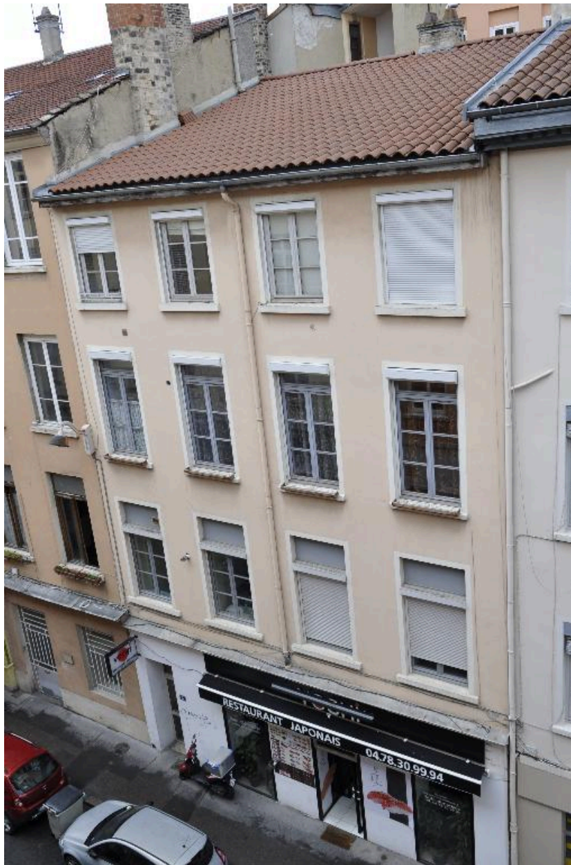
Vue d'ensemble du n°5 rue Dumenge
