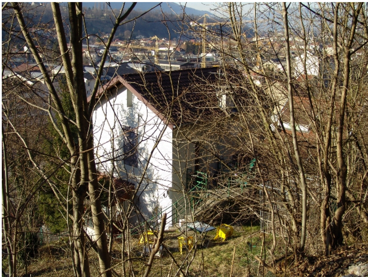
Vue depuis l'arrière
