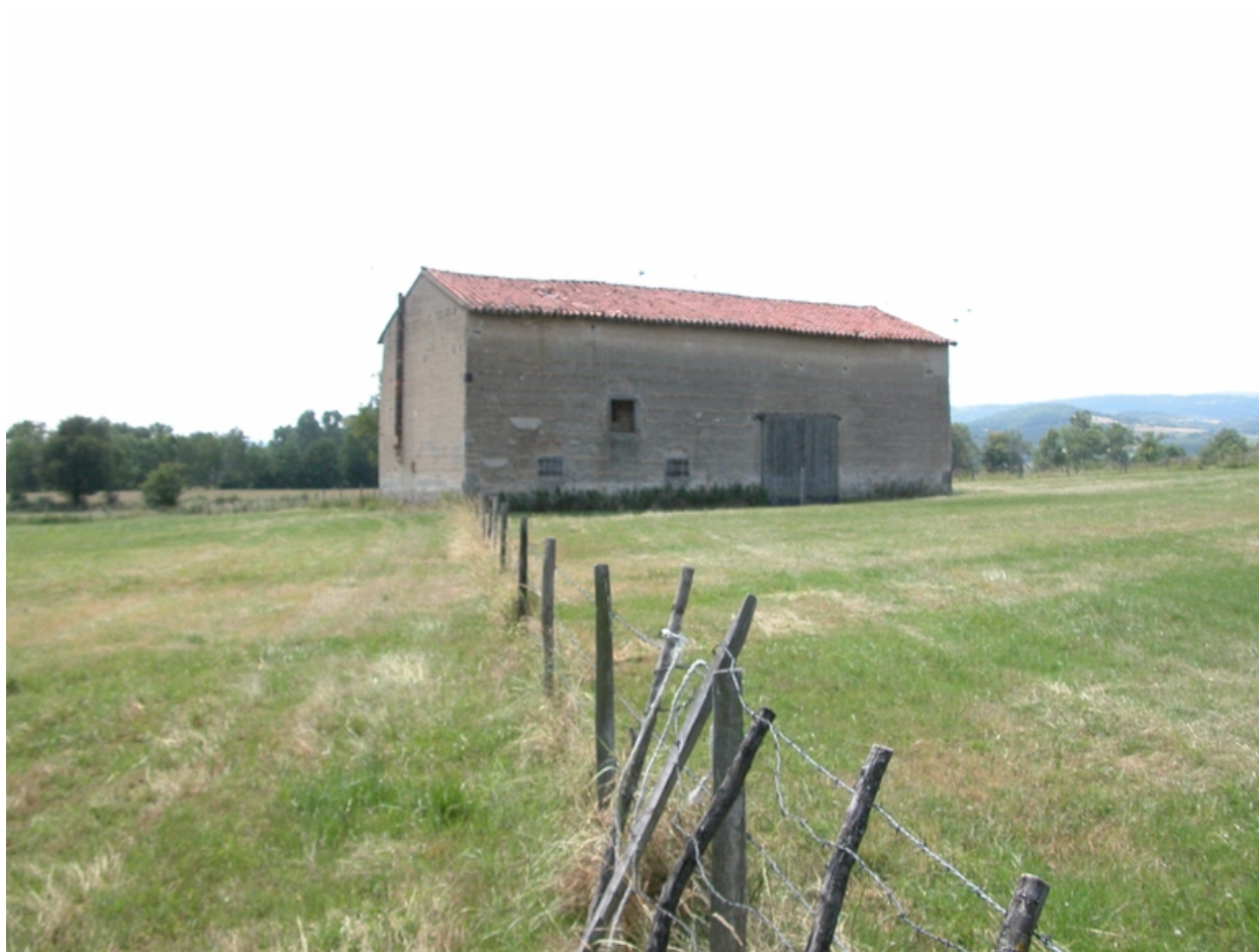
Vue générale (façade nord).
