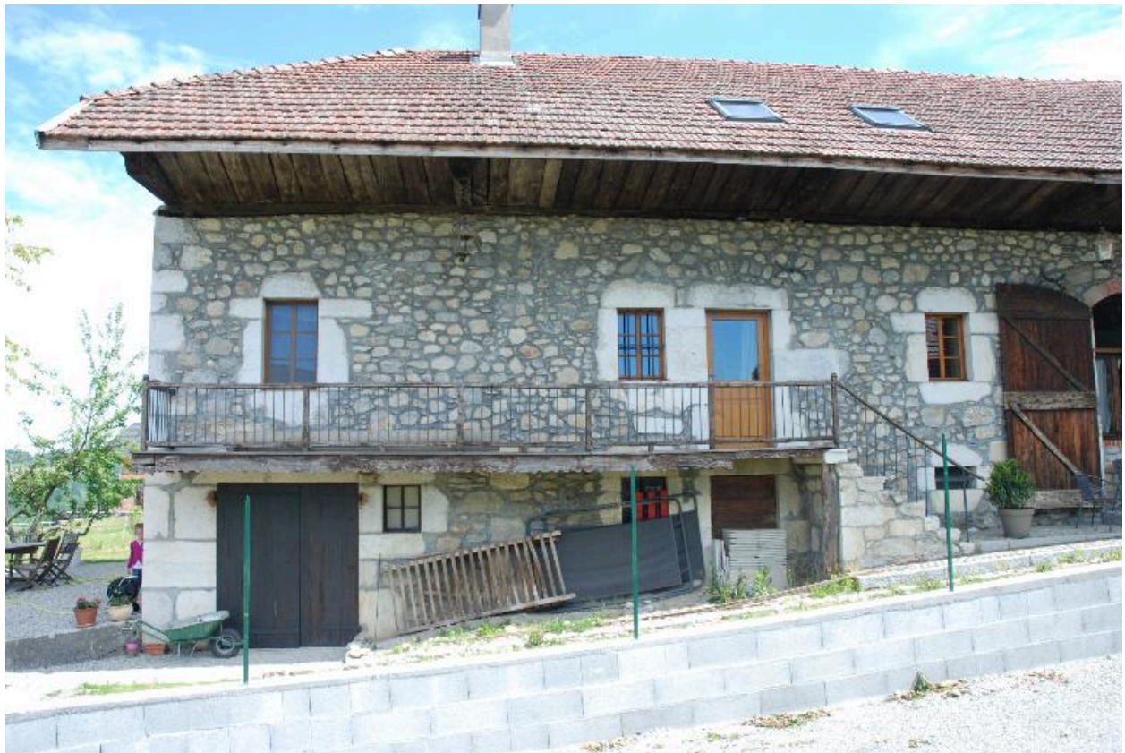
Vue d'ensemble, partie habitation.
