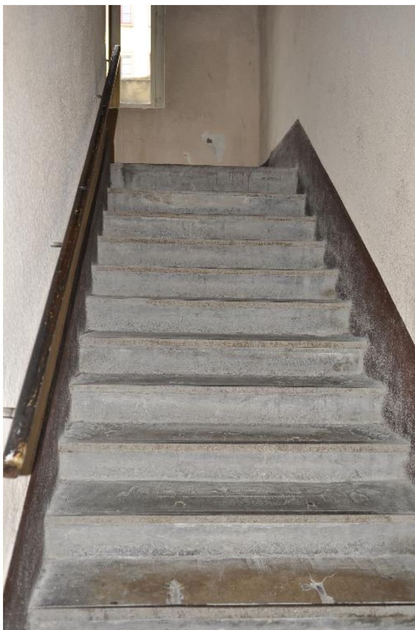
Marches enduites de l'escalier du n°15 rue Dumenge
