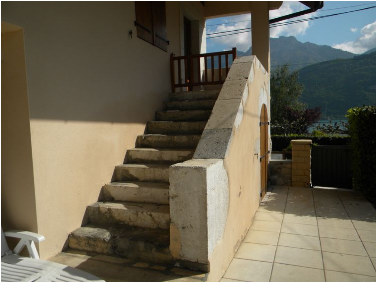
Vue de l'escalier extérieur d'une ancienne ferme remaniée (2008 A3 3547).
