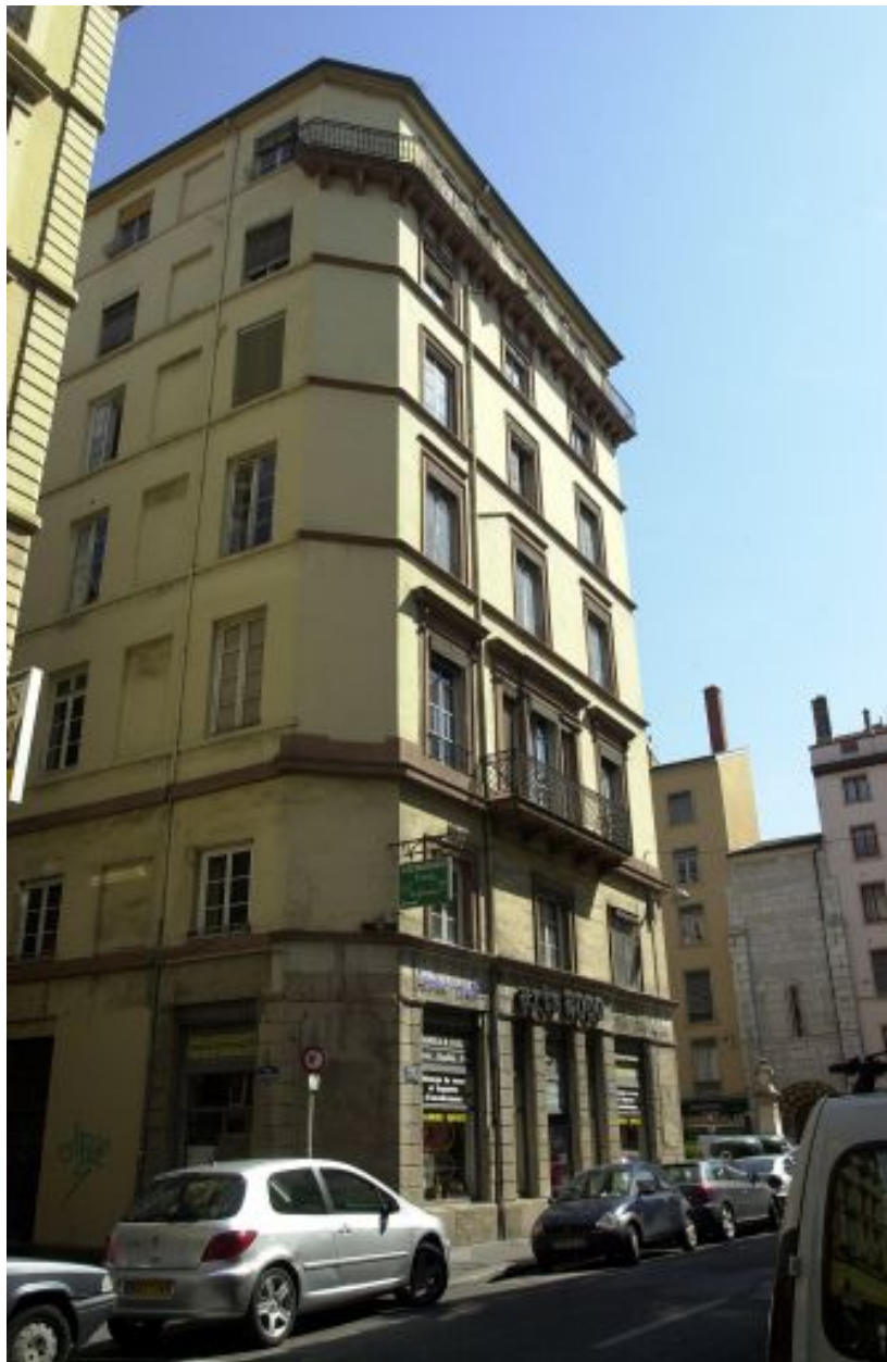
Façade sur la rue de la Platière
