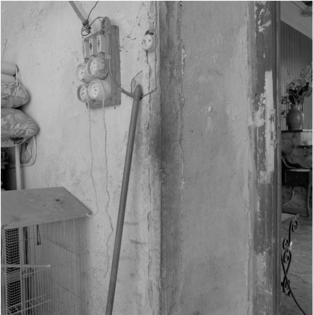
Vue intérieure, rez-de-chaussée de la maison : détail d'un ébrasement du mur en pisé séparant le vestibule et la partie ouest de la maison.
