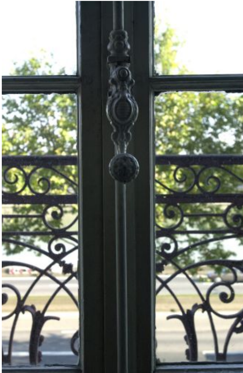
Détail de l'espagnolette de la porte-fenêtre donnant sur le balcon du 2e étage
