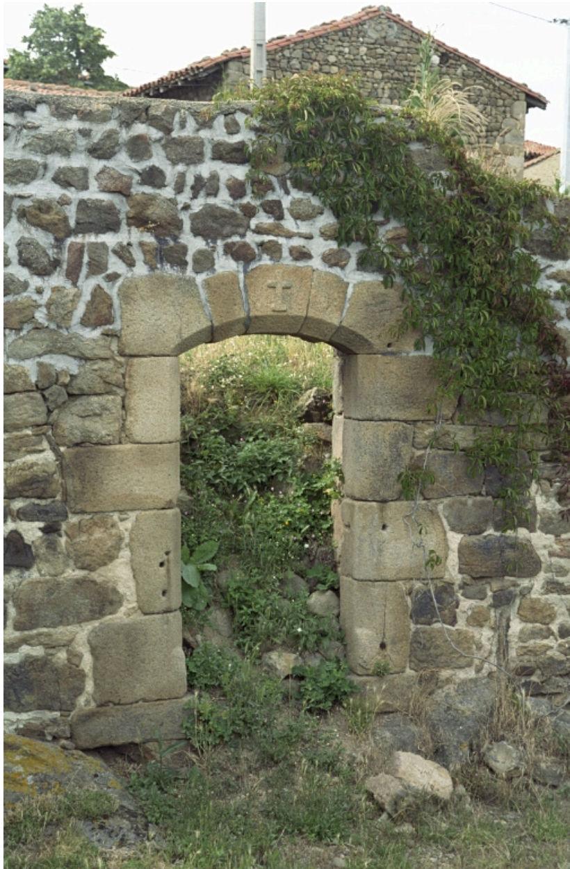
Ferme à Eculieux (B4 986), détail d'un portail avec linteau sculpté d'une croix.
