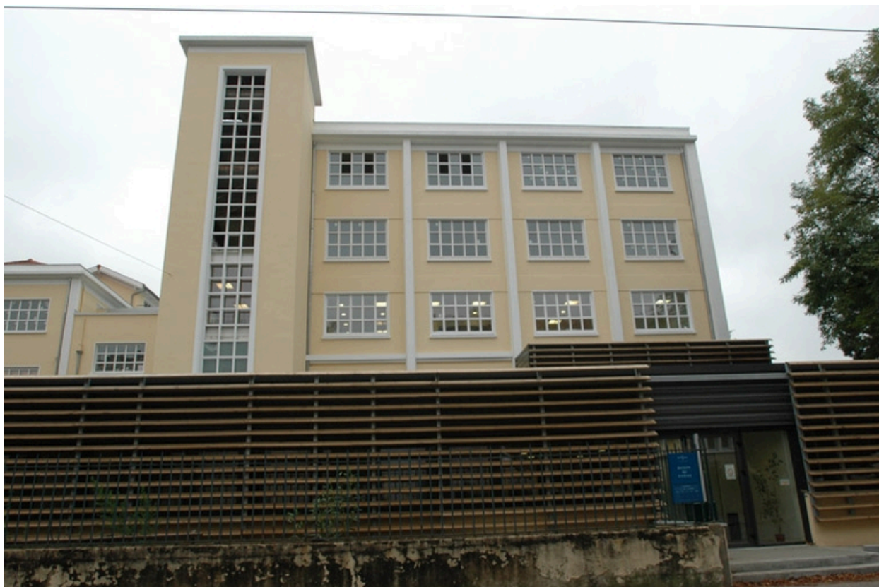
Détail extension : architecture bois
