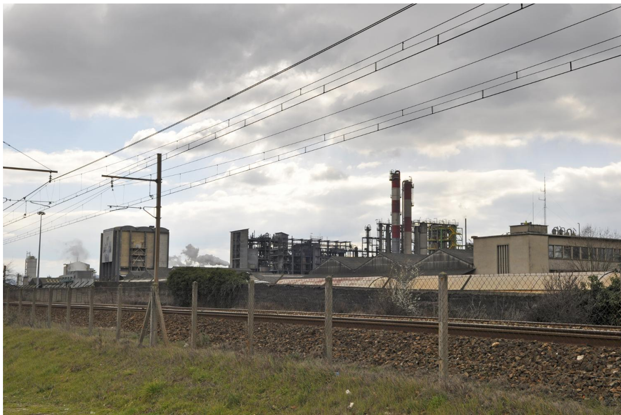
Voie ferrée qui borde l'usine
