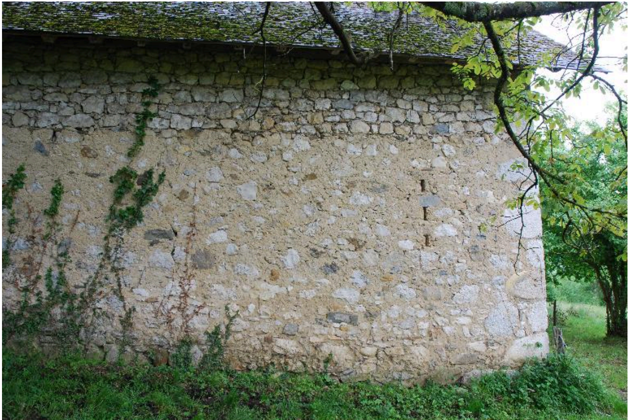
Détail de la façade arrière.
