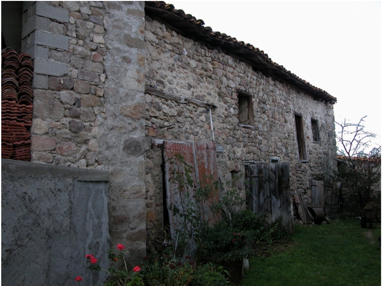
Ferme aux Brosses, type A1 (non repérée, 1986 A 60). Grange-étable sur cour.
