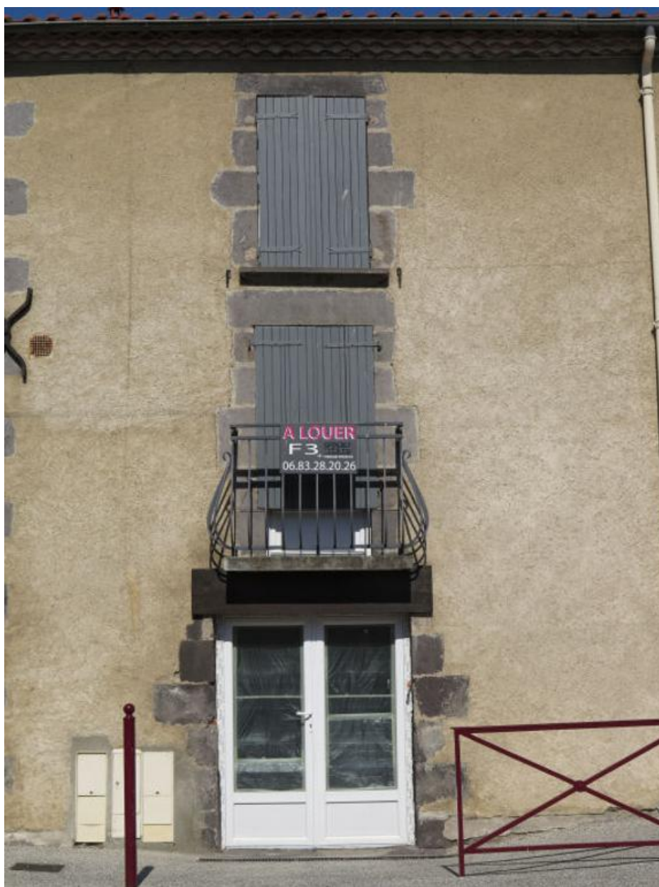
Vue partielle de la façade latérale
