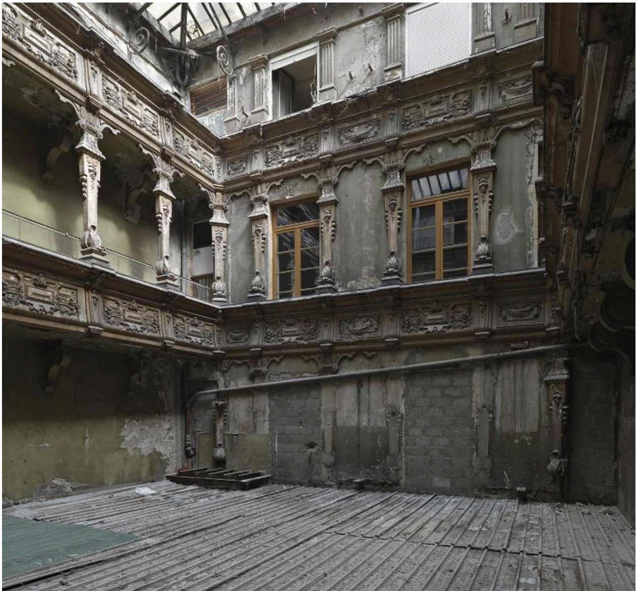
Cour, vue d'ensemble depuis le sud-est
