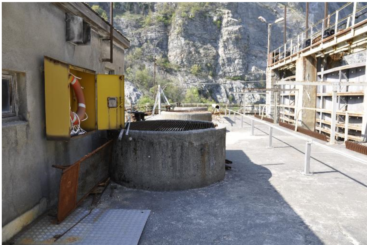
Vue des installations
