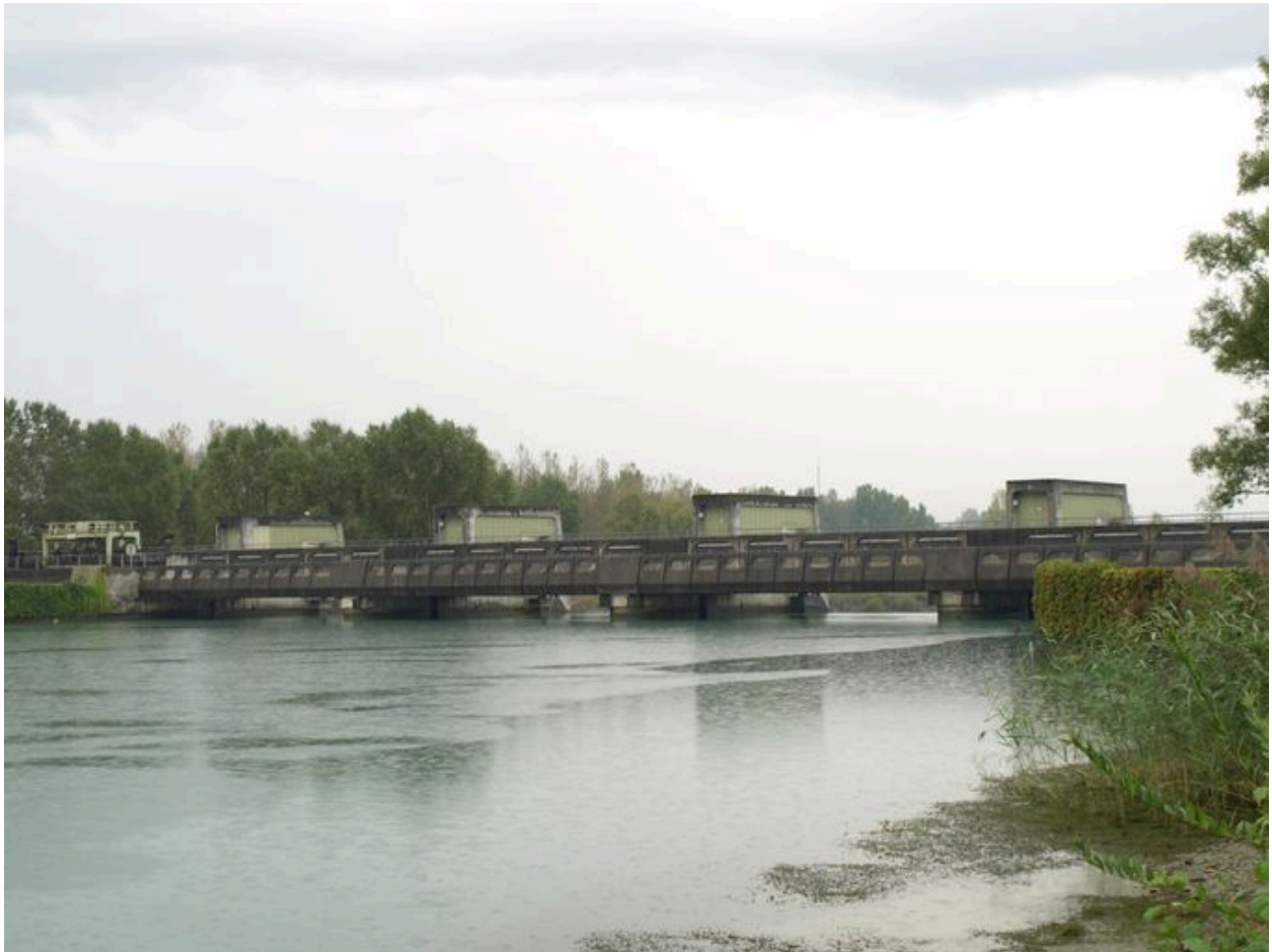
Pont, face amont (depuis la rive droite)
