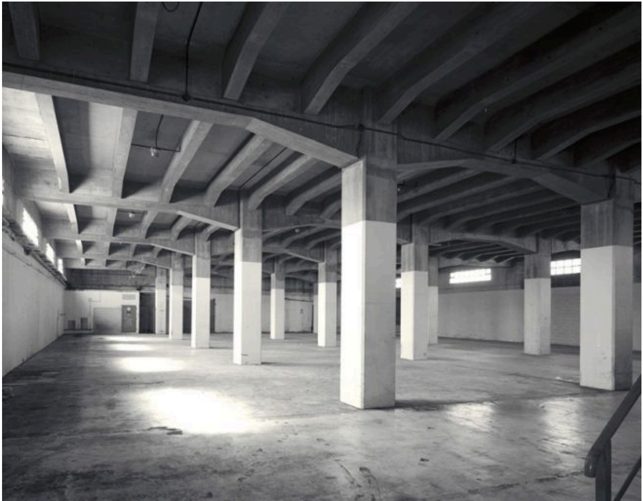
Intérieur du bâtiment de 1960 (bâtiment nord) : vue depuis l'angle nord-est
